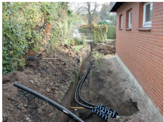
Die Leitungen sind verlegt und der Hausanschluss fertig
