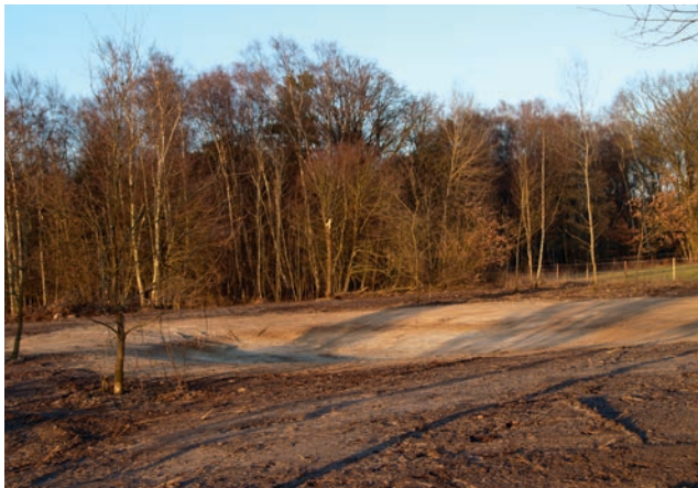
Hier sind neue Teichanlagen entstanden
