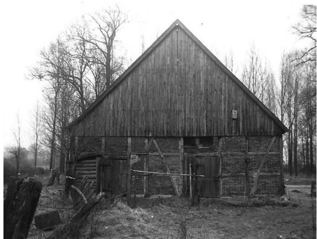
So sah die alte Bauernkate vor der Sanierung aus
