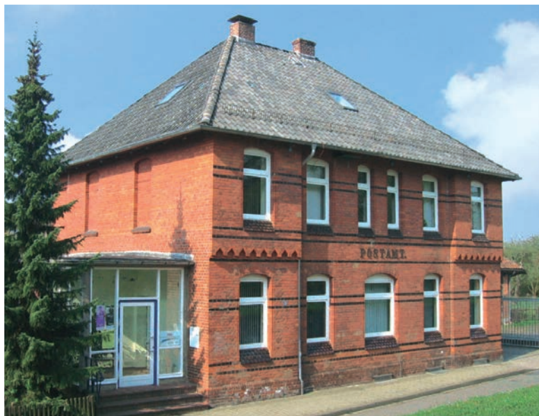
Kanzleisitz: Ehemaliges (kaiserliches) Postamt in Bleckede, Schloßstr. 23
