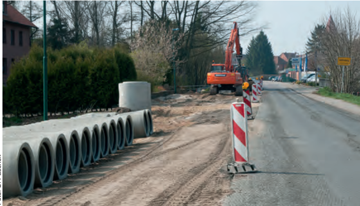
Im Zuge der Baumaßnahmen wird auch die Kanalisation erneuert
