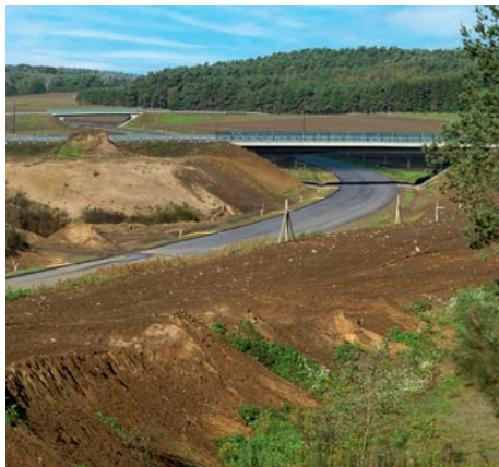
Die Ortsumgehung Dahlenburg kurz vor ihrer Fertigstellung im Jahr 2003
