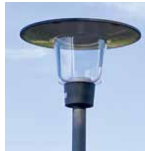
Einer der neu installierten LED-Lampenköpfe in Bleckede
