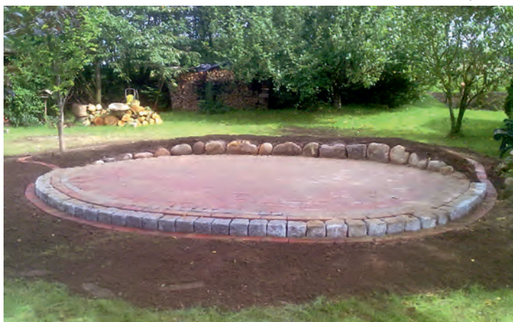
Pflasterung mit Beeteinfassung und Findlingsreihe
