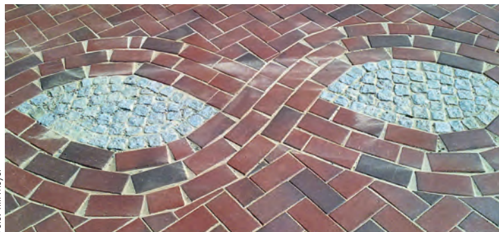
Ein Beispiel der vielfältigen Pflasterarbeiten
