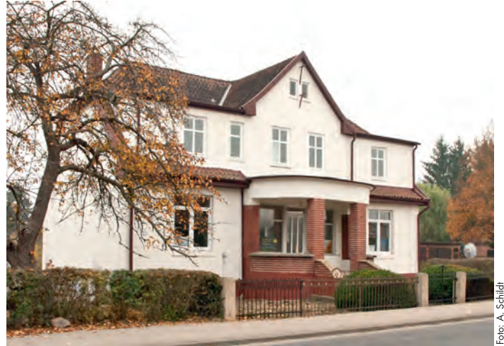
Das neue Domizil der Kanzlei Einhäuser in der Dahlemburger Bahnhofstraße
