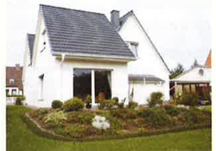
Aufstockung zweier Kinderzimmer in Dahlenburg
