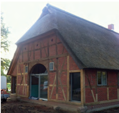
Die Sanierung alter Bausubstanz wird mit viel persönlichem Engagement durchgeführt
