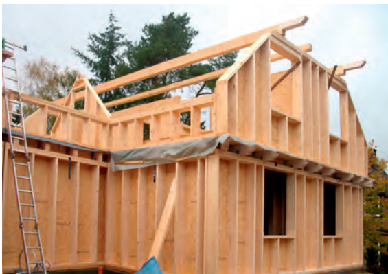
Holzrahmenbau im Neubau
