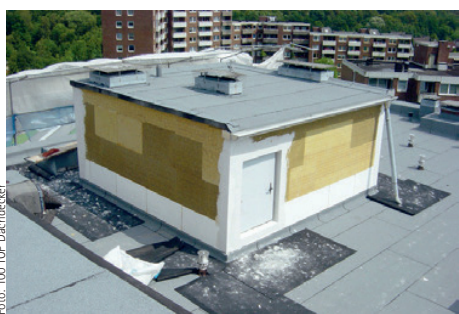
Foto: 100 TOP Dachdecker
