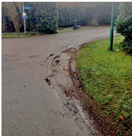
Einfahrt in den Erlenweg, Lüdersburg
