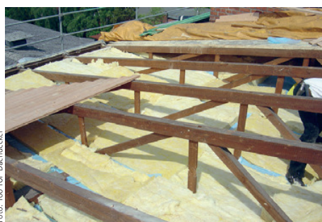
Foto: 100 TOP Dachdecker
