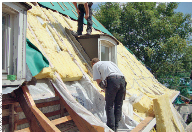
Foto: 100 TOP Dachdecker
