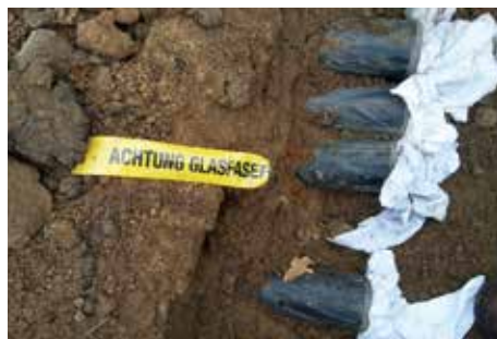
Der Glasfaserausbau in der Samtgemeinde Scharnebeck geht weiter
