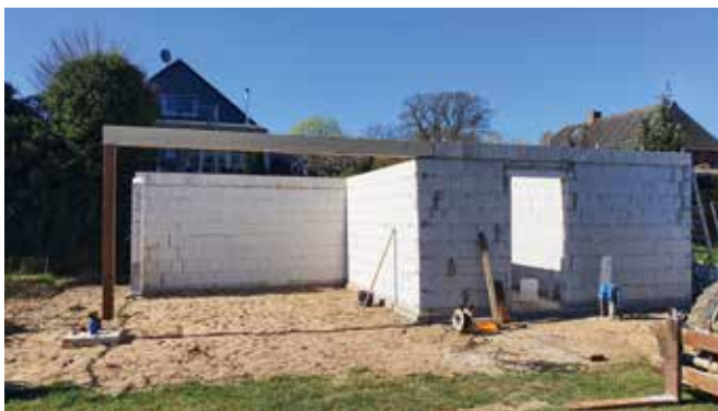
Der Rohbau des Unterstands an der Boulebahn ist fertiggestellt
