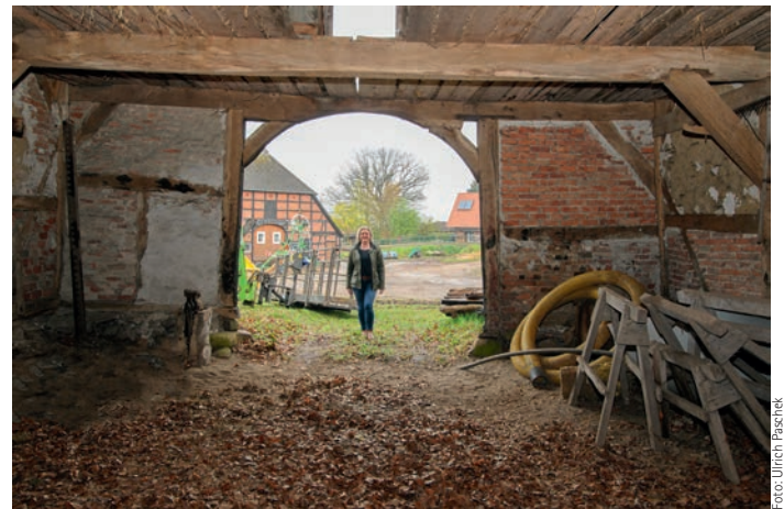
Das originale Gebälk ist noch fast vollständig intakt
