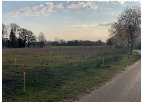
Die Erschließung des Baugebiets Hinter dem Kirchhof hat begonnen
