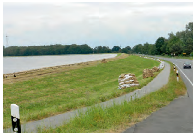
Nur wenige Zentimeter fehlen bis das Wasser die Oberkante des Deichs berührt
