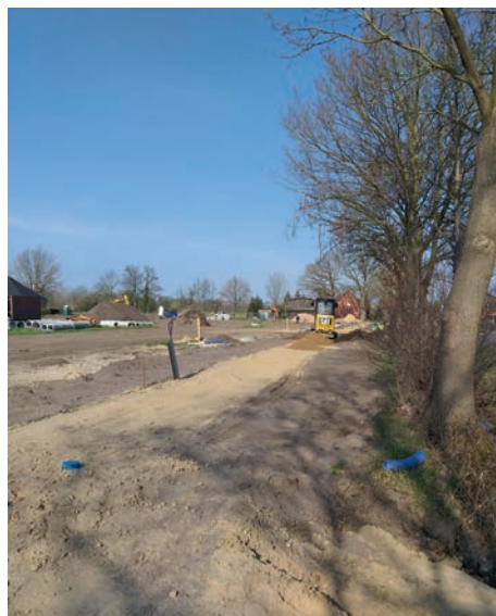
In Kürze kann der Baubeginn in Brietlingen erfolgen
