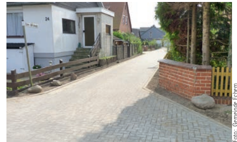
Die Erschließungsarbeiten an der Straße Zum Blöcken sind abgeschlossen
