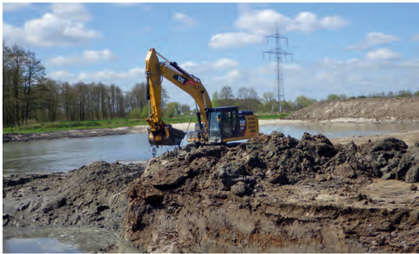
Bagger förderten den für den Deichbau wichtigen Klei an die Oberfläche
