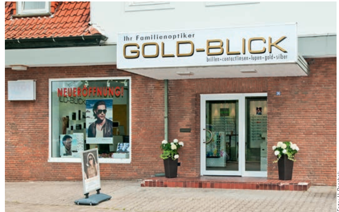
Außenansicht des komplett sanierten Geschäfts in der Hauptstraße
